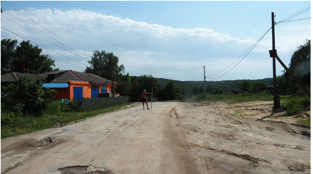
Рис. 15. Калужская область. Ферзиковский район. 2022 год. Археологическое обследование по трассе строительства канализации в п. Дугна. Точка фотофиксации 3. Вид с севера.
