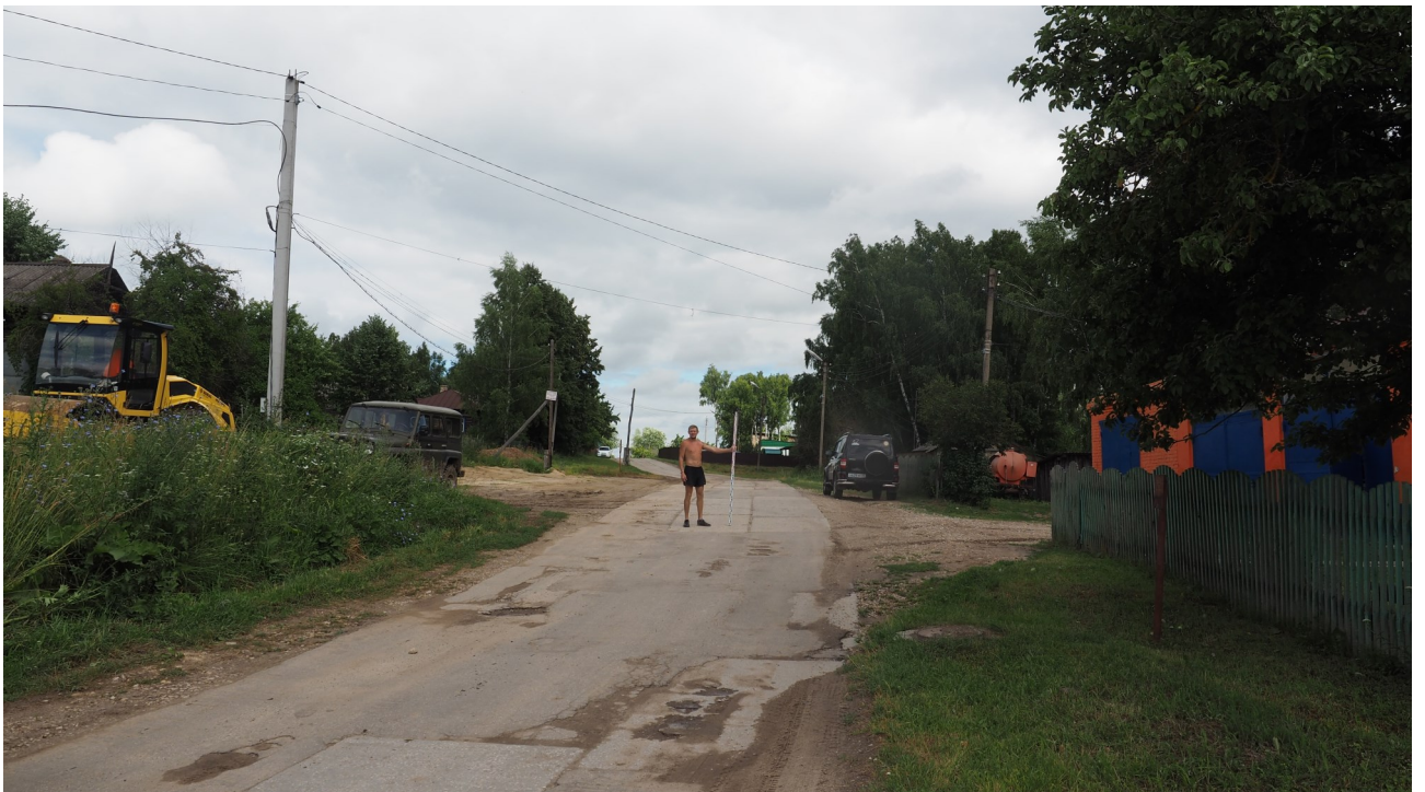
Рис. 38. Калужская область. Ферзиковский район. 2022 год. Археологическое обследование по трассе строительства канализации в п. Дугна. Точка фотофиксации 13. Вид с юга.
