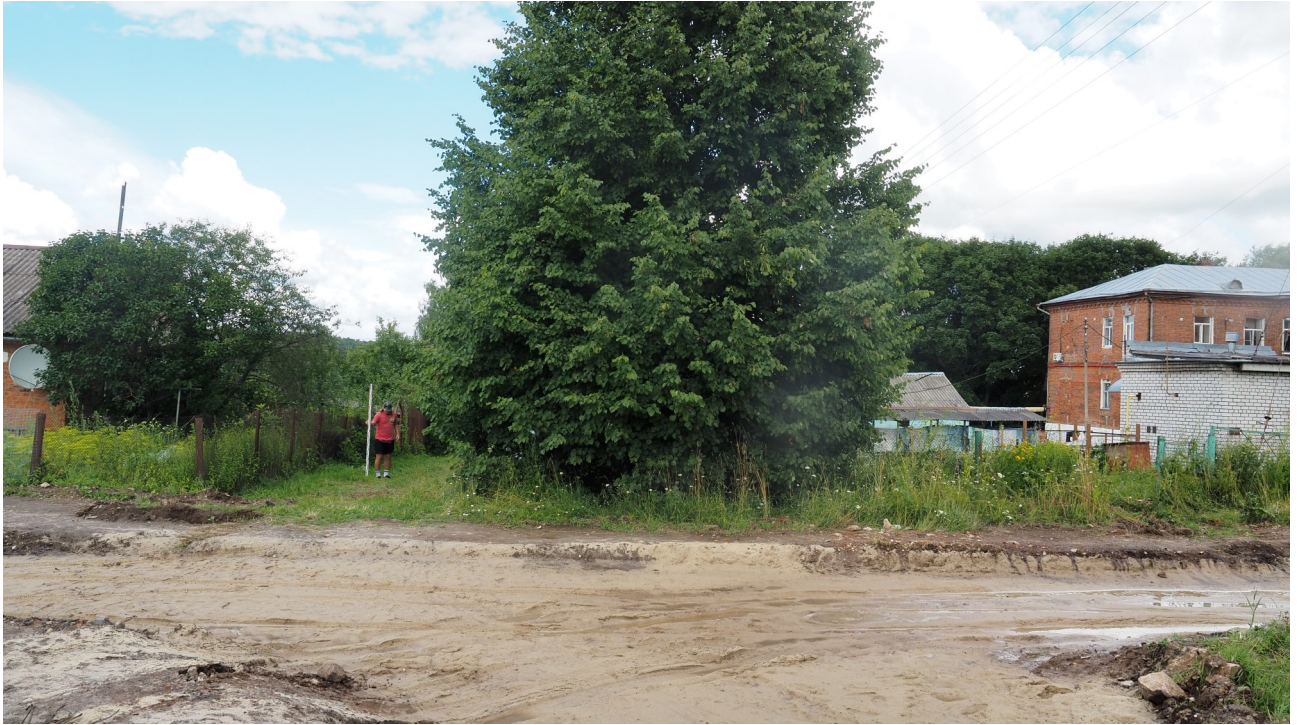
Рис. 51. Калужская область. Ферзиковский район. 2022 год. Археологическое обследование по трассе строительства канализации в п. Дugna. Точка фотофиксации 17. Вид с юго-запада.
