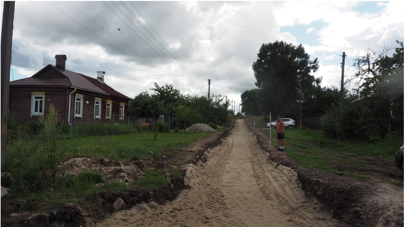
Рис. 49. Калужская область. Ферзиковский район. 2022 год. Археологическое обследование по трассе строительства канализации в п. Дugna. Точка фотофиксации 17. Вид с северо-востока.
