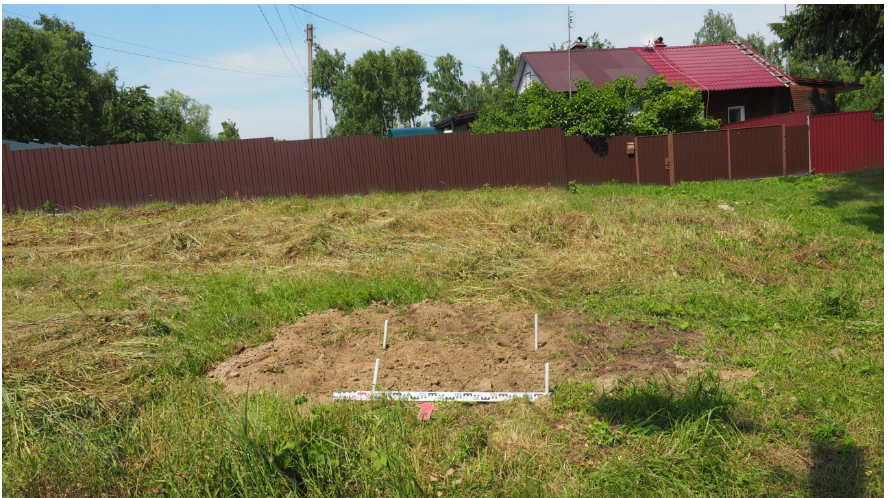
Рис. 70. Калужская область. Ферзиковский район. 2022 год. Археологическое обследование по трассе строительства канализации в п. Дугна. Шурф 2 после рекультивации. Вид с юга.
